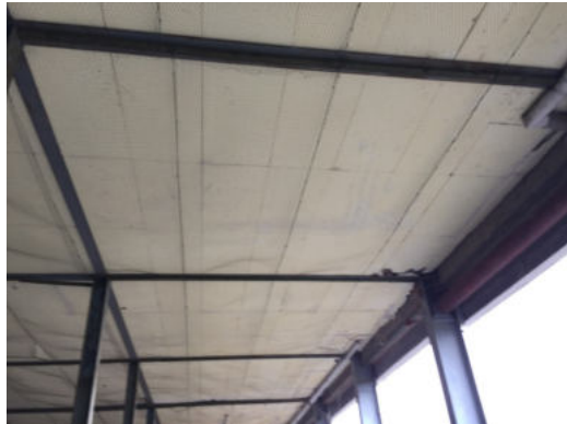
Foto 2: Nischen und Spalten Beispiele in der Lagerhalle
