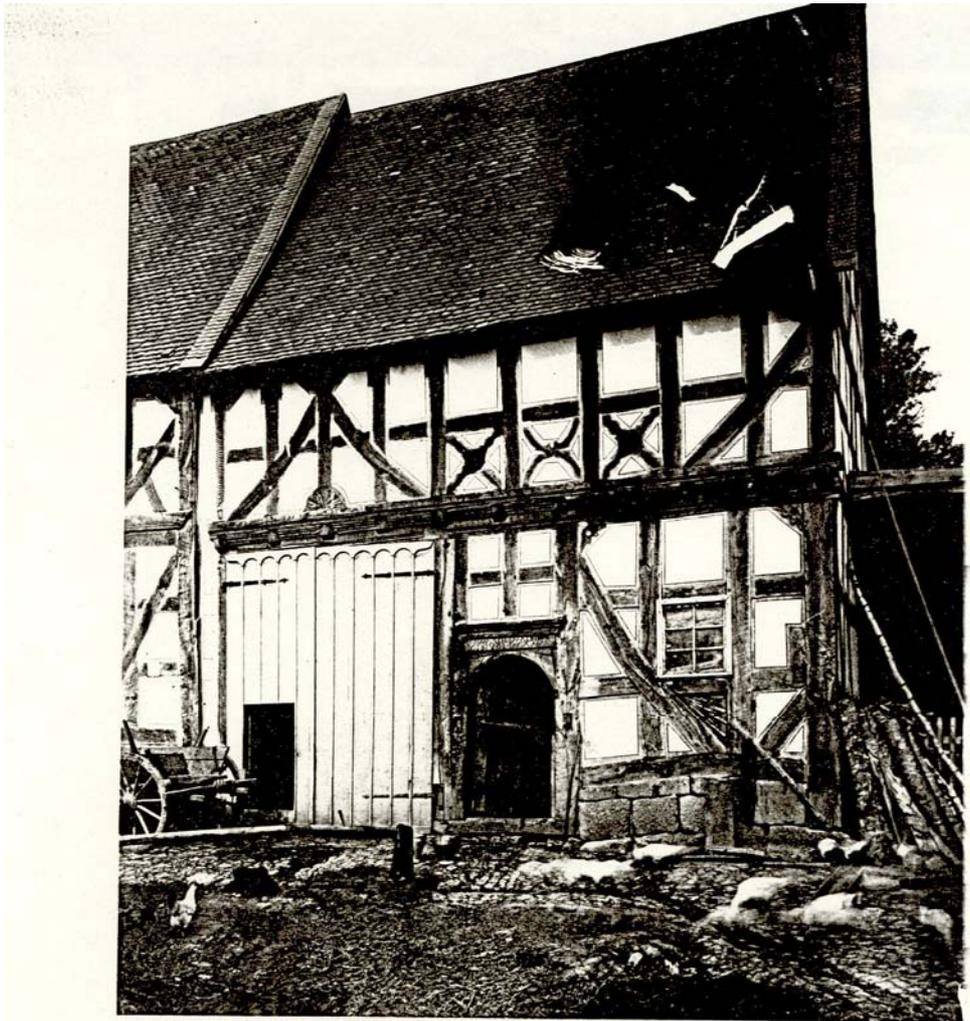
Teil des alten Scheunen- und Stallgebäudes des Hermes-Hofes aus dem 17. Jahrhundert, 1911 durch einen Neubau ersetzt. Das mittlere der drei Balkenkreuze blieb erhalten und wurde bei der letzten Renovierung in das Fachwerk der Scheune eingefügt. Aufgenommen von Ludwig Bickell, um 1890 (Bildarchiv Foto Marburg 810.554)
