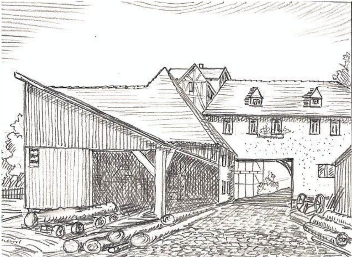
Die Nähemühle war eine Sägemühle, das Bild zeigt sie 1920. Die Strasse nach Ronhausen führt durch das Anwesen. Die Gebäude sind teilweise abgerissen, und durch Neubauten ersetzt. Heute treibt das Wasser Turbinen zur Stromerzeugung an.
