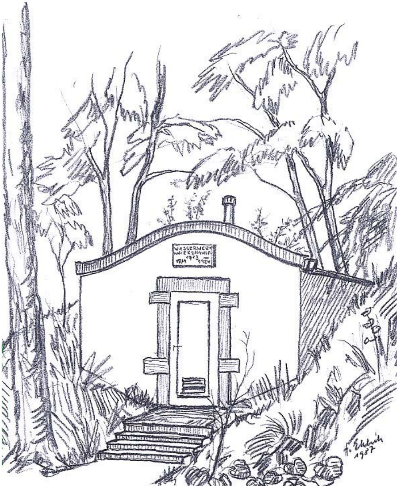
Bereits 1913 wurde dieser Hochbehälter gebaut. Man nutzte das natürliche Gefälle, um die Haushalte mit fließendem Wasser zu versorgen. Das Wasser wird heute noch von der Landwirtschaft genutzt.
